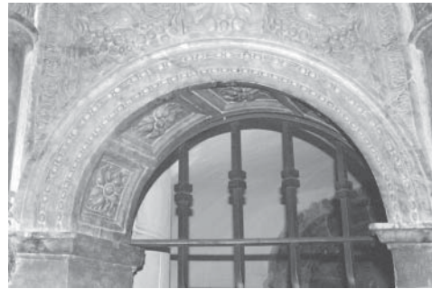
Figura 18. Arco esviado monolítico en la capilla de la Resurrección de la catedral de Valencia.
