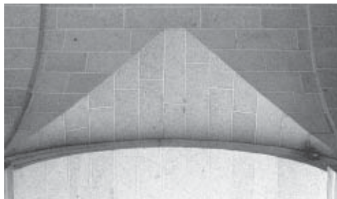
Figura 24. Luneto apuntado y capialzado en el acceso al Patio de los Reyes de El Escorial.
