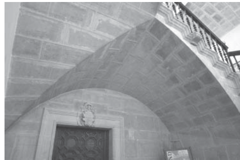
Figura 36. Escalera aduclida en cercha del Colegio de Santo Domingo en Orihuela.
