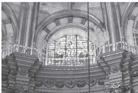
Figura 27. Arco en vuelta de horno en la cúpula de la catedral de Granada.
