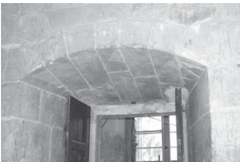
Figura 30. Capialzado desquijado cuadrado en el segundo cuerpo de la torre de la Catedral de Murcia.
