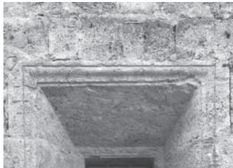
Figura 32. Capialzado a regla monolítico en el Palacio de Carlos V de Granada.
