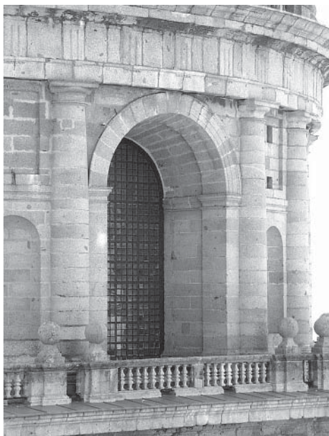
Figura 23. Arco abocinado en torre cavada en el tambor de la cúpula de la basílica del Escorial.
